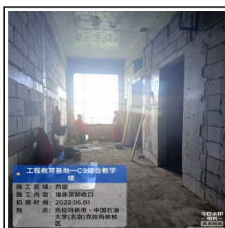
墙体顶部收口
