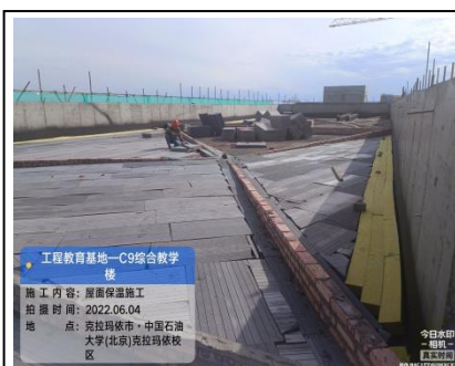
屋面保温施工
